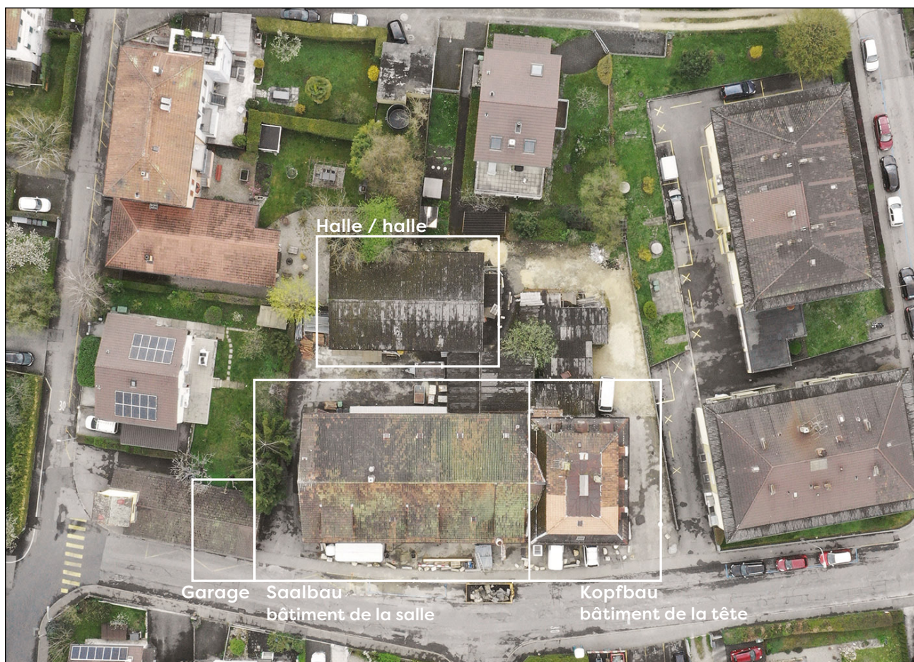
Luftaufnahme bestehende Gebäude / Vue aérienne des bâtiments existants
