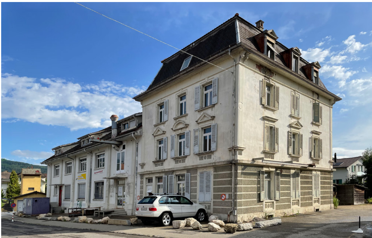
Siedlung Finkenweg heute / Lotissement « Chemin des Pinsons » aujourd'hui
