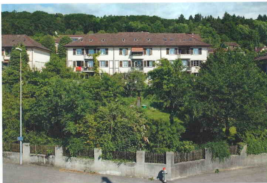
Architekt Eduard Lanz erstellte die Siedlung Sonnhalde nach der Gartenstadt-Philosophie.
